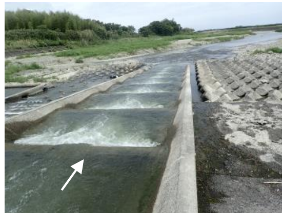
新設：台形断面式魚道
