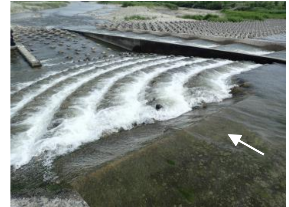
新設・扇形柵田式魚道
