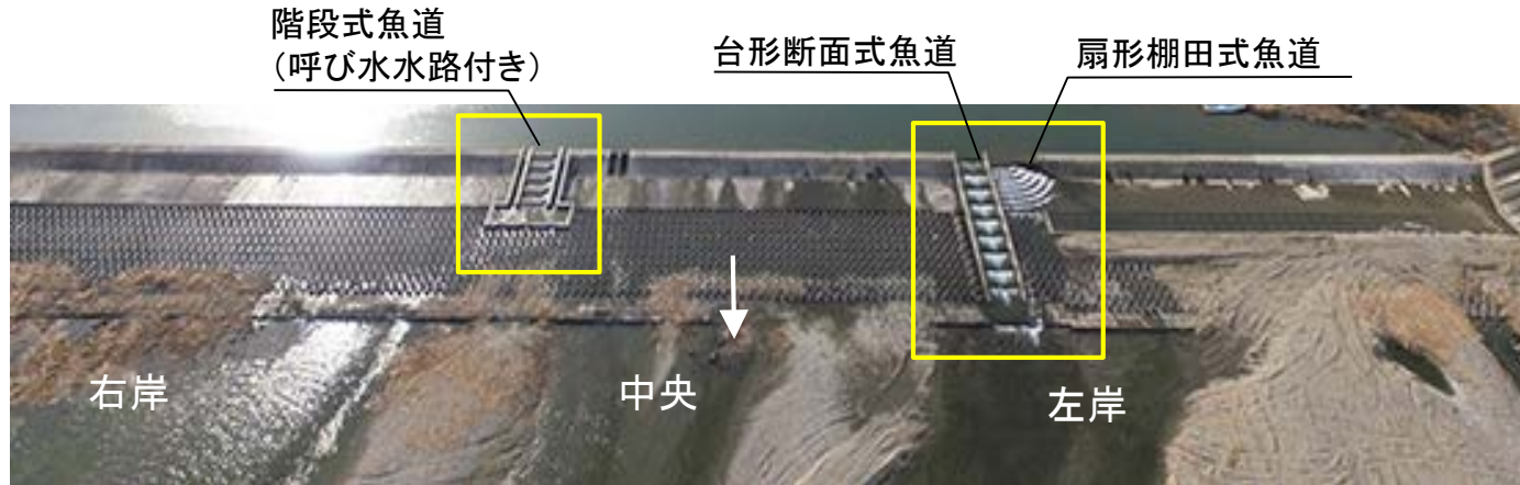
改良：階段式魚道(呼び水水路付き)
