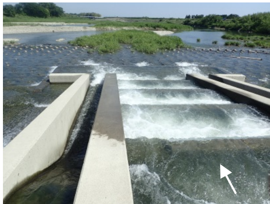
改良：階段式魚道(呼び水水路付き)
