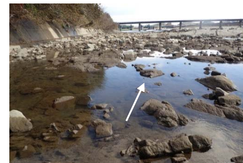
左岸の岩盤露出部のたまり (H29.12堰減水操作時)
