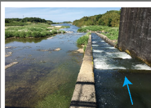
右岸魚道全景
