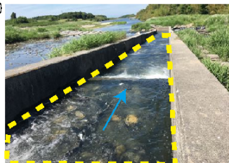
⑥ 〇延伸区間 (H3 施工) は魚道プール水深が大きく、アユ等が滞留しやすいと考えられる。既往文献・知見を参考として、大型土のうを設置してプール水深を 40cm 程度にした。
