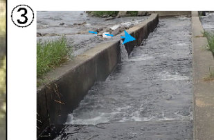
③ 〇魚道側壁からの越流水が多い場合は影響が考えられるので、土のう積み等に対応した。
