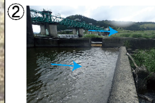
② 〇側壁開口部は魚道下流側に通水するため、隔壁を設置し、閉塞した。
