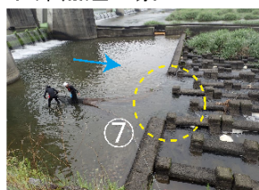
右岸ゲート下流の水叩きと隔壁開口部
