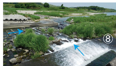
⑥ 用水余水放流口と右岸側護床工の全景
