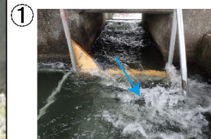
① 〇魚道出口部 (開口部) は流速が速い区間が長く、出口部下流に阻流板を設置し、流速を低減した。
