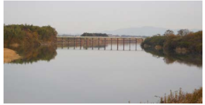
かつては畑利用されていたが、現在は樹木が繁茂している。(榊田川大平橋付近)
