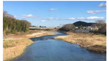
河原に樹木やヨシ等の植生が繁茂 河床には土砂が堆積(榊田川両郡橋下流)
