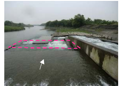
振り返り部の高落差、速い流速部を遡上できず途中のプールに滞留する個体が多い。
