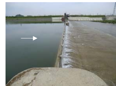
水叩き、護床工は流速が0.5～1m/s程度と稚アユが滞留しやすい環境となっている。
