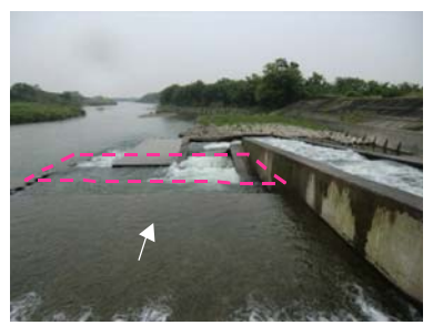
折り返し部の高落差、速い流速部を遡上できず途中のプールに滞留する個体が多い。
