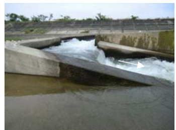
魚道折返部では、隔壁間の落差が60cm以上と大きく、流速も2m/sを越えている。
