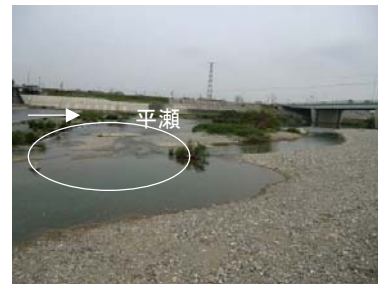
護床工から河道部に砂州が形成し、4つの滞筋をつくり魚類の横断方向の移動を分断。砂州には、樹木が繁茂し始めている。
