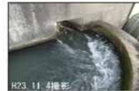
魚道出口部のプールは水深0.9m程度で、外湾側の流速が速い。
