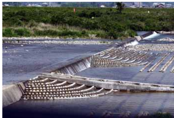
「棚田式魚道」（根尾川第8床固工）の流れの様子
