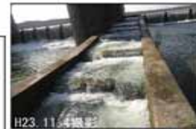
当初施工区間の落差は0.2mで、切り欠きは幅0.8m、高さ0.2m
