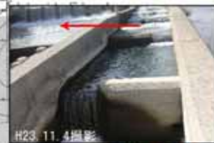
側壁の開口部（角落とし）
