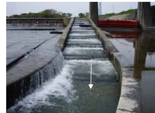
左岸階段式魚道上流区間
