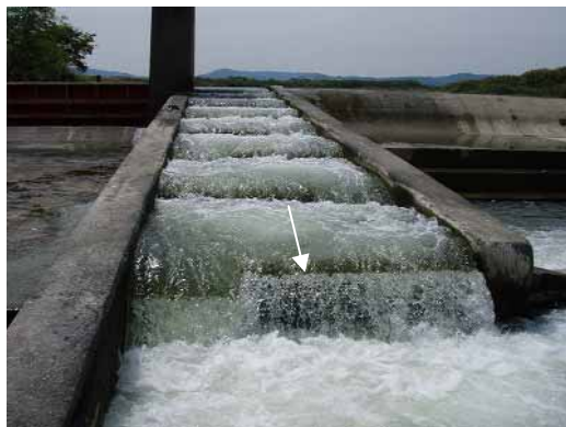
右岸階段式魚道上流区間
