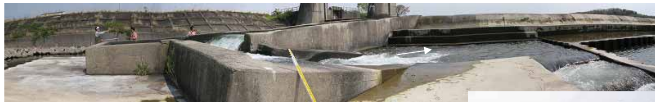
右岸階段式魚道折り返し区間
