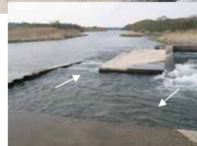
右岸階段式魚道下流区間
