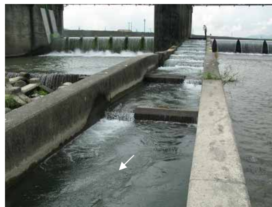
右岸階段式魚道下流区間
