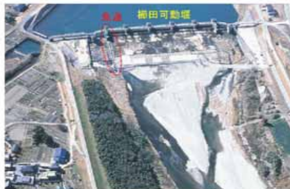
右岸魚道（階段式） （下流延伸）
