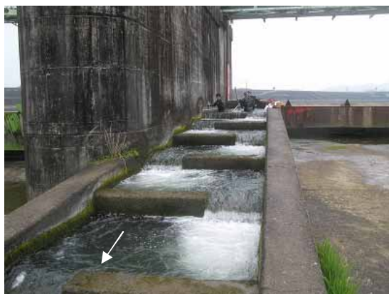
右岸階段式魚道上流区間
