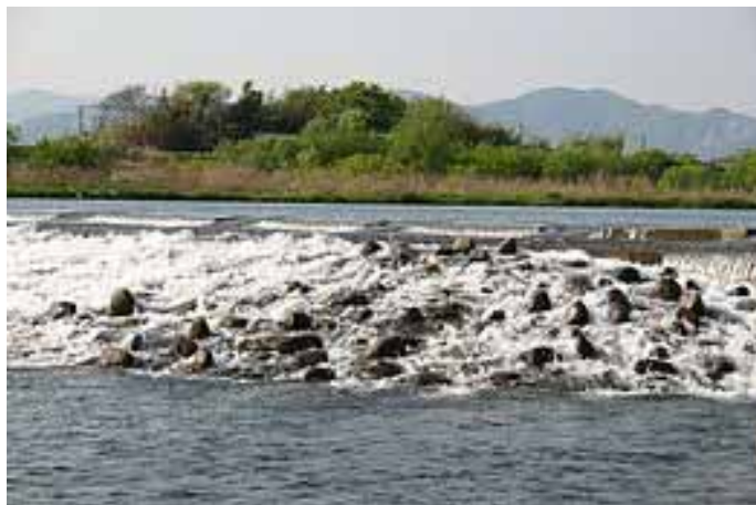
「自然石パノラマ魚道」（揖斐川支流・根尾川）の自然河川の早瀬の流れを模した扇形魚道の様子
