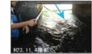
魚道出口は、流速2m/sを超えることから、流速の低減を図る必要がある。
