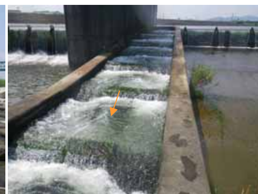
櫛田可動堰 魚道上流部 形式：階段式 魚道幅：3.0m 勾配：1/17
