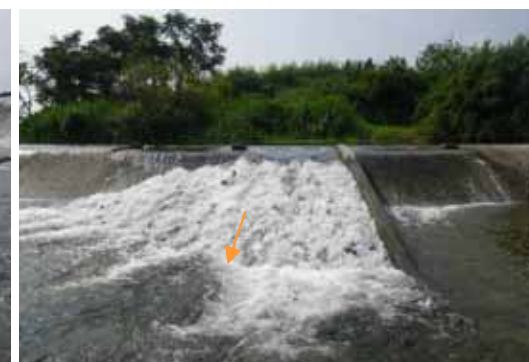
東黒部頭首工 左岸魚道 形式：粗石付き斜路式 魚道幅：9.2m 勾配：1/7
