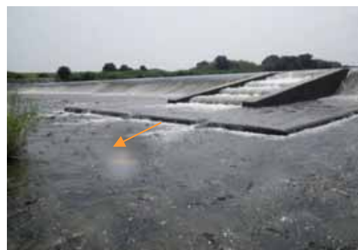
東黒部頭首工 中央魚道 形式：階段式 魚道幅：3.5m 勾配：1/8
