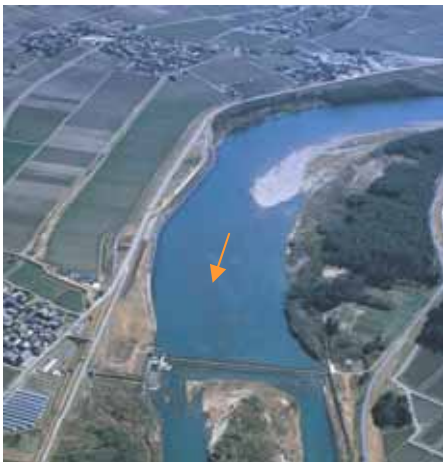
櫛田川第一頭首工上流の湛水域
