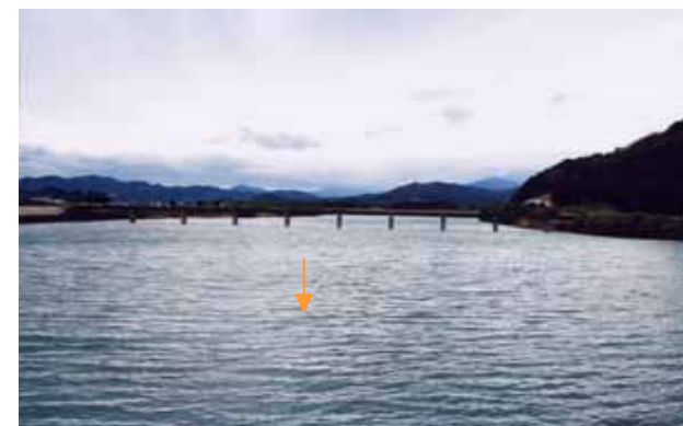
湛水域 (櫛田可動堰上流)
