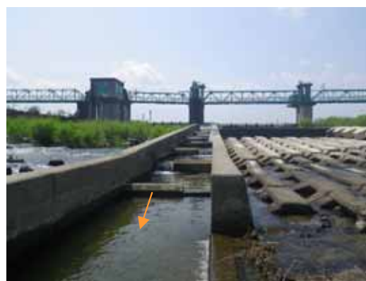
櫛田可動堰 魚道下流部 形式：階段式 魚道幅：3.0m 勾配：1/17
