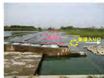
魚道入り口が水叩き直下より下流に突出しており、水叩き直下に滞留した魚類は魚道入り口を見つけにくい（迷入により滞留）。
