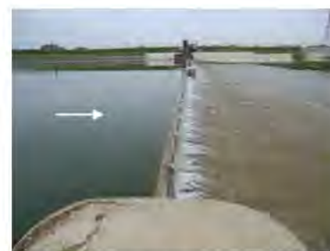
水叩き、護床工は流速が0.5~1m/s程度と稚アユが滞留しやすい環境となっている。
