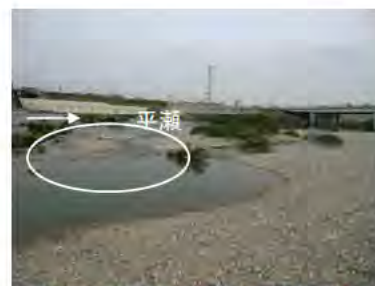
護床工から河道部に砂州が形成し、4つの滞筋をつくり魚類の横断方向の移動を分断。砂州には、樹木が繁茂し始めている。
