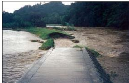
津市一志町田尻（9/29～9/30洪水時）
