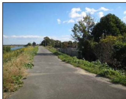
② 中村川右岸堤防より下流を望む
