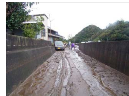
② H21 台風18号出水状況 (堆積土 地元清掃状況)
