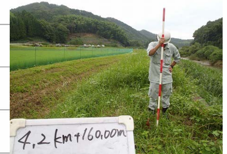
測量実施状況
