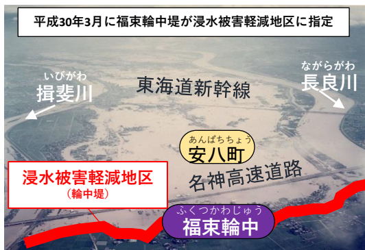
福東輪中堤(昭和51年9月 台風17号浸水時)
