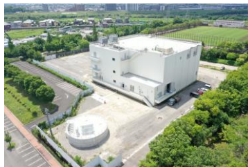
雨水ポンプ場
