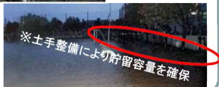
【校庭を活用した貯留施設】
