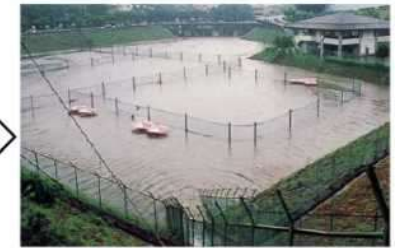
雨水貯留浸透施設の例(防災調整池)
