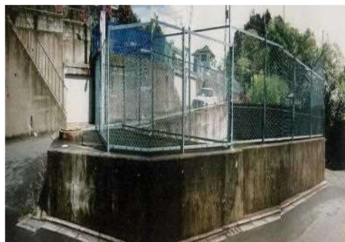
従前の防災調整池
