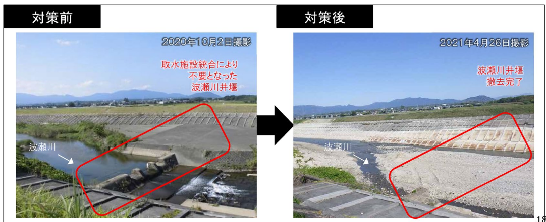
図 22 波瀬川下流部堰撤去事業（波瀬川井堰）
