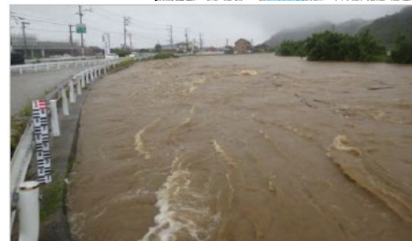
平成26年8月台風第11号 波瀬川3.4k付近
