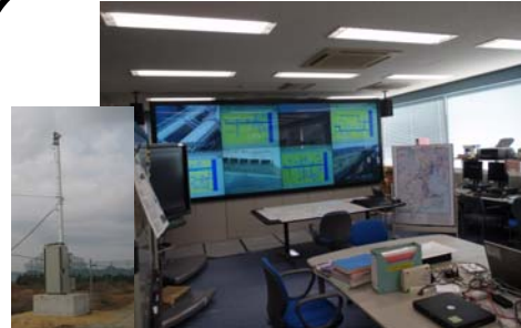
CCTVカメラ映像(約130台) ※4水系+西南海岸 (広域的情報収集)
