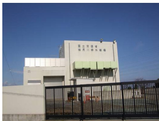
図 2-6 桧尻川排水機場ポンプ増強
