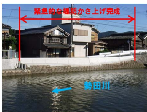
図 2-2 特殊堤防設置状況（北新橋右岸下流）
