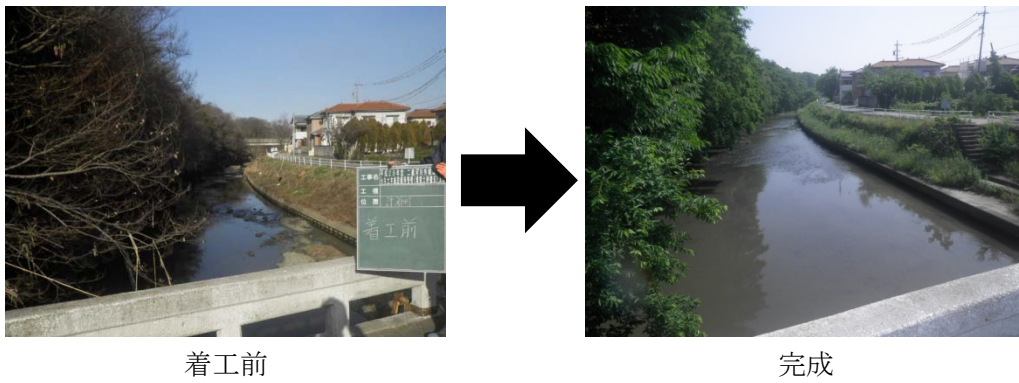
図 4-4 土砂撤去状況（三重県管理区間）
