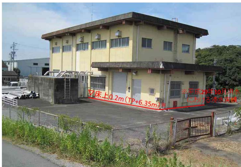
図 4-3 汁谷川排水機場
