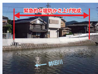
特殊堤防設置状況 (北新橋右岸下流)
