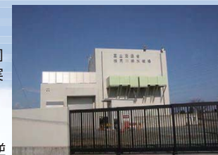
桧尻川排水機場ポンプ増強
