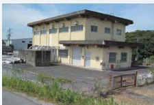
汁谷川排水機場
