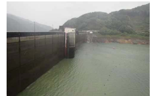
①洪水調節前(10/12 9:30頃) (予備放流実施後) EL.427.04m
