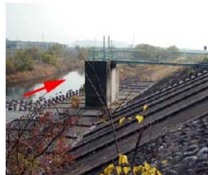
堤防の損傷なし
