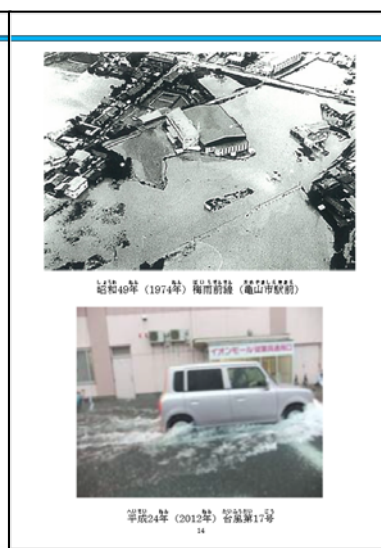
(例) 昭和49年(1974年) 梅雨前線 亀山市駅前での被害
