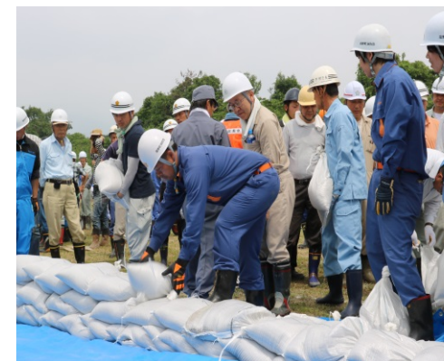
積み土のう工法の訓練
