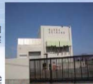
椋尻川排水機場ポンプ増強
