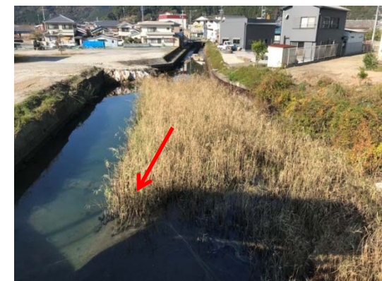
H30 施工予定箇所(下流側)
