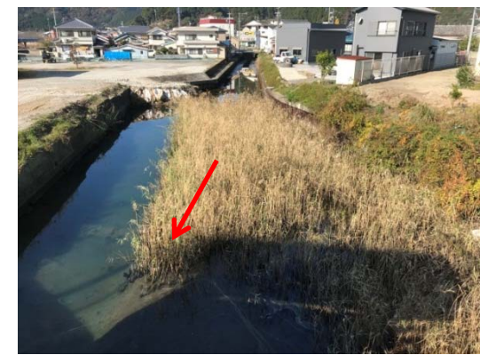
H30 施工予定箇所(下流側)
