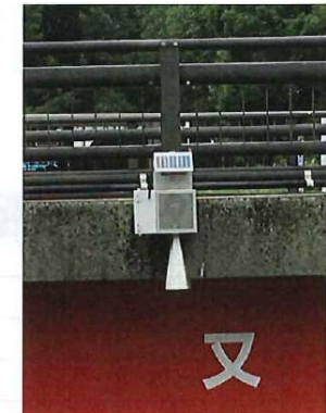
危機管理型水位計設置イメージ
