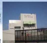
椋尻川排水機場ポンプ増強
