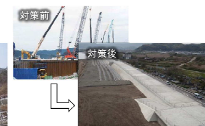
海岸堤防の耐震対策
