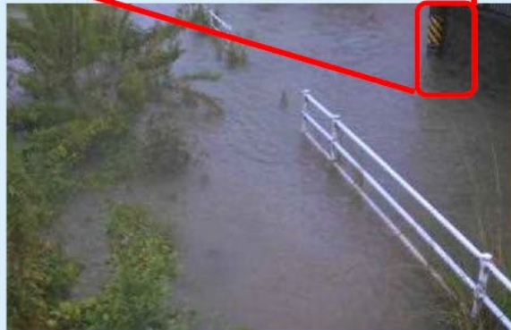
浸水センサー設置箇所が浸水している状況
