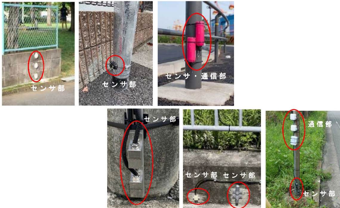
実証実験で設置した浸水センサの設置事例
