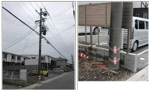
岡崎市矢作学区センサ設置箇所
