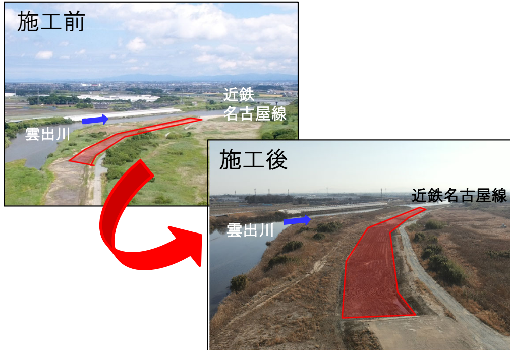
R4年度護岸整備実施状況 雲出川右岸7.6～8.6k
