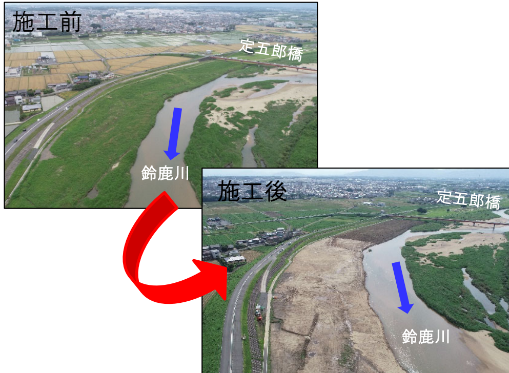
R3年度樹木伐採実施状況 鈴鹿川右岸10.7k付近
