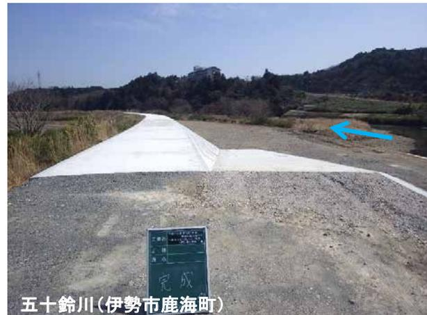
現堤防を補強することで、越水した場合には法肩部の崩壊の進行を遅らせることにより、決壊までの時間を少しでも延ばす。
