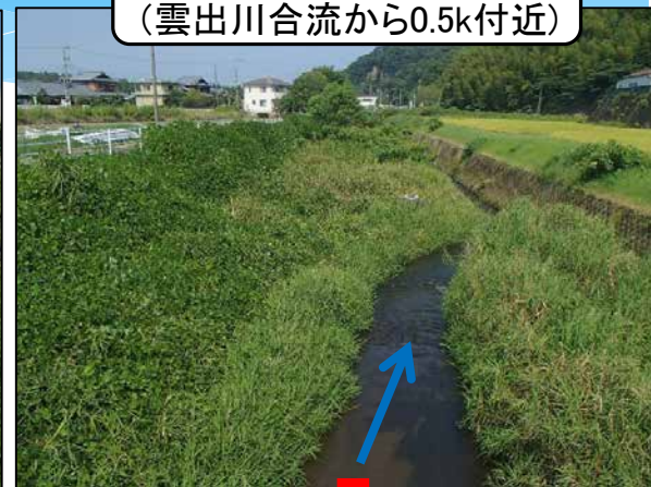
一級河川弁天川 (雲出川合流から0.5k付近)
