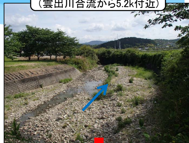
一級河川大村川 (雲出川合流から5.2k付近)
