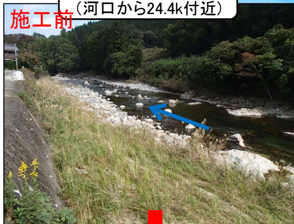
一級河川雲出川 (河口から24.4k付近)
