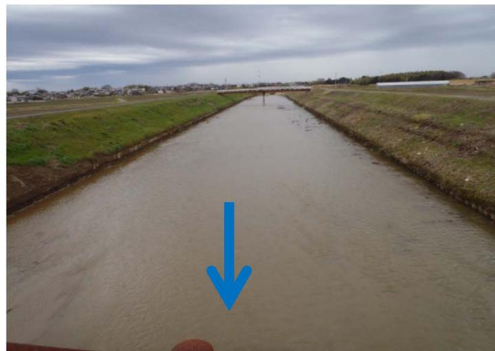
堆積土砂を撤去し従前の流下能力を確保
