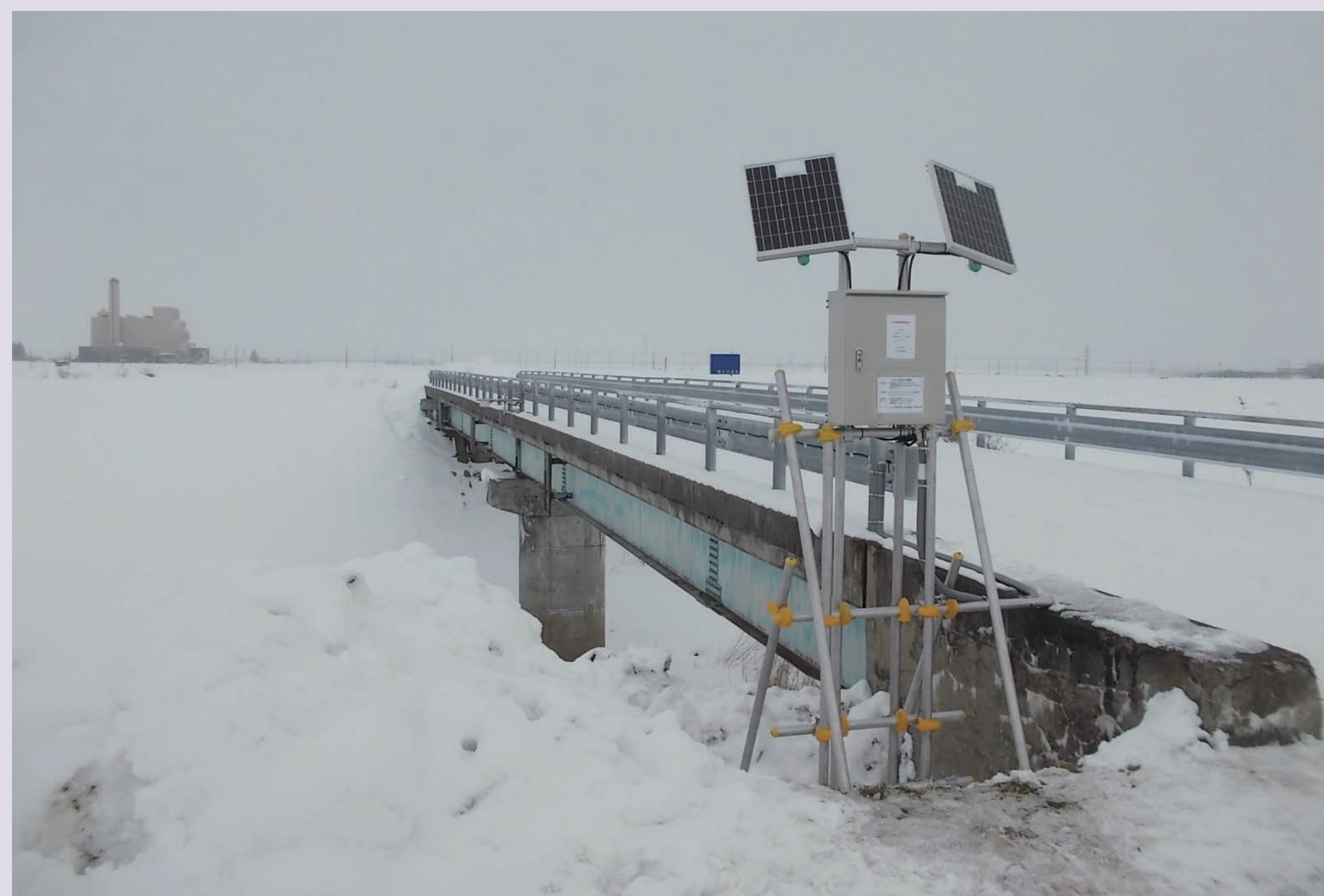
現場実証実験第二弾※寒冷地仕様(最上川水系)
