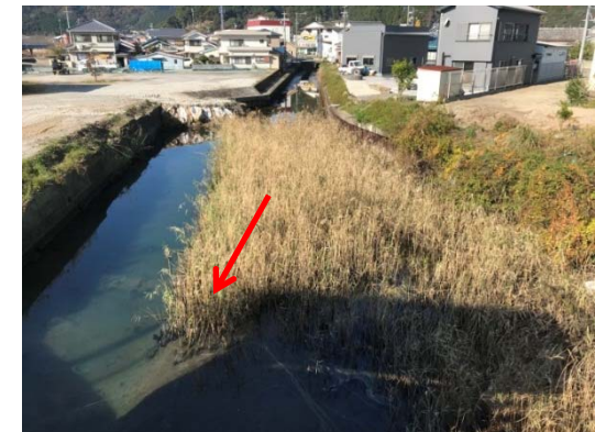
H30 施工予定箇所(下流側)
