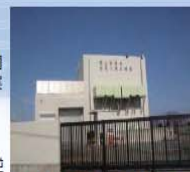
椋尻川排水機場ポンプ増強
