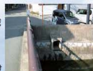
逆流防止フラップ弁設置予定の排水管
