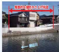
特殊堤防設置状況 (北新橋右岸下流)
