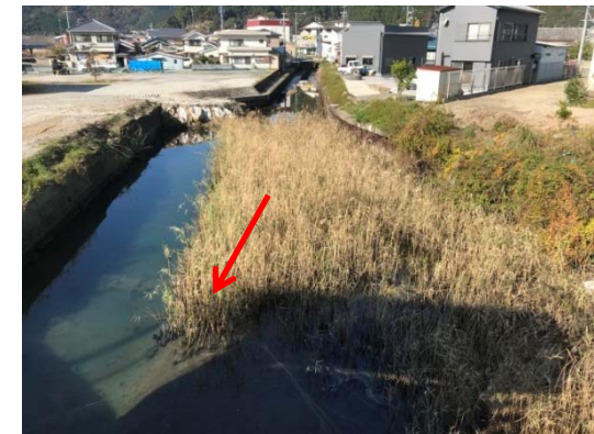
H30 施工予定箇所(下流側)
