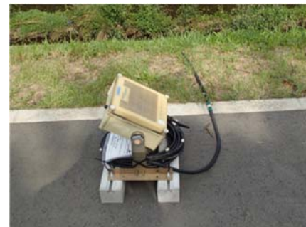
堤防に設置するタイプ （ケーブル(計測器)を河川に入れて計測)
