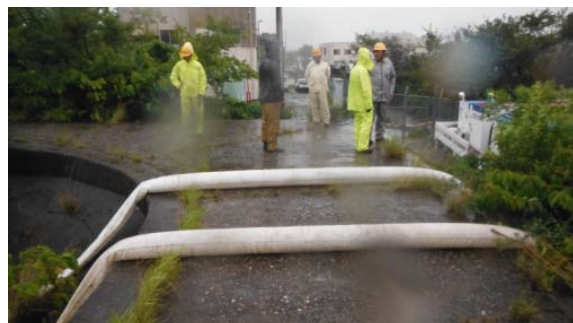
排水ポンプ車による排水作業実施状況
