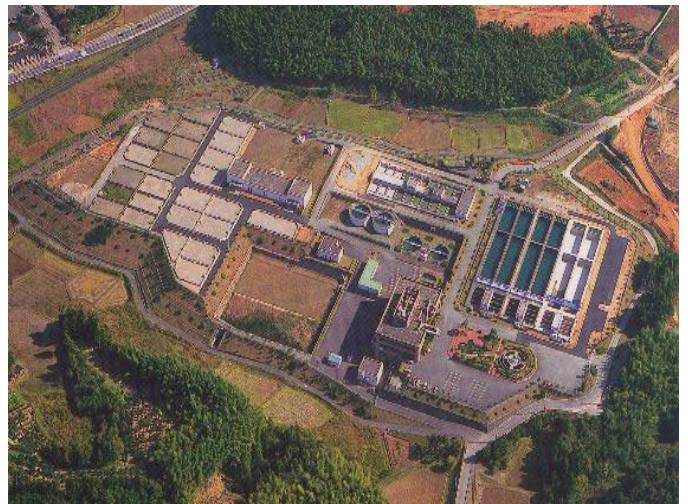
たきじょうすいじょう 多気浄水場
