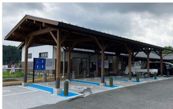
屋根付き駐車場
