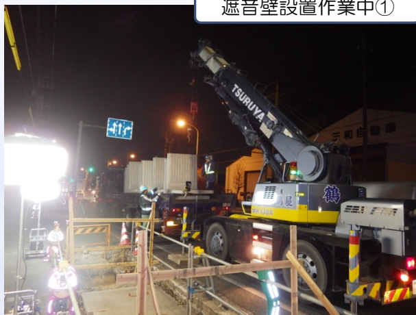
遮音壁設置作業中①
