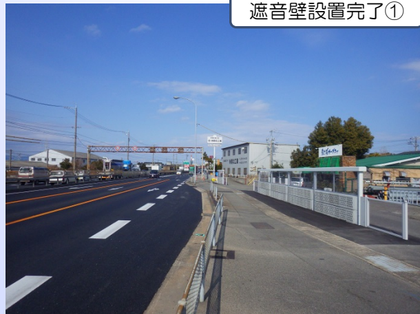
遮音壁設置完了①
