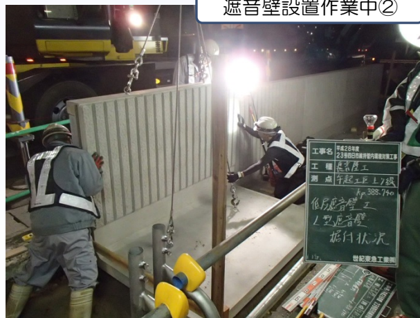
遮音壁設置作業中②
