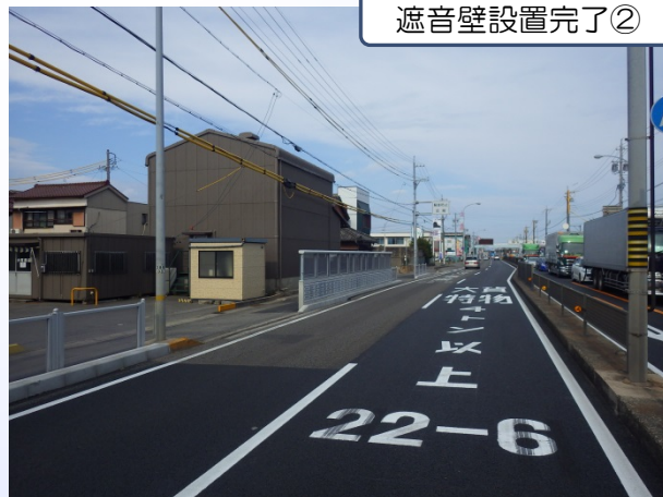
遮音壁設置完了②
