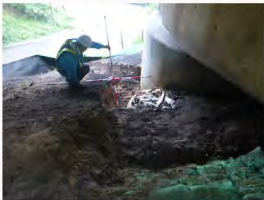
【法面点検の様子】
