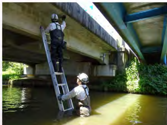
【河川内の梯子による点検の様子】
