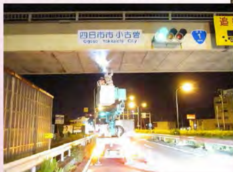
【歩道橋の点検の様子】
