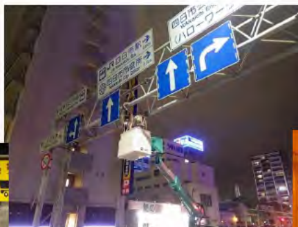
【案内標識の点検の様子】
