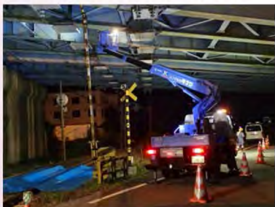
【鉄道交差部の橋梁点検車による夜間点検の様子】
