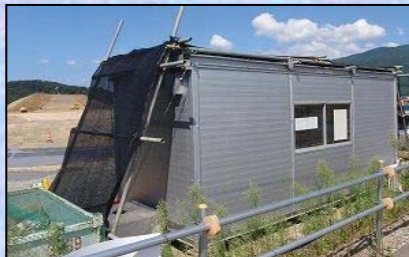
遮光シートを設置し熱を遮断
