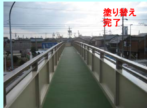
【国道1号 四日市市 東富田歩道橋】
