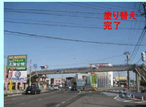
【国道1号 四日市市 東富田歩道橋】
