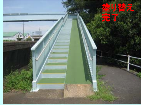
【国道23号 四日市市 霞ヶ浦歩道橋】
