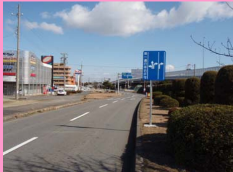
交差点改良工事 (施工前)
