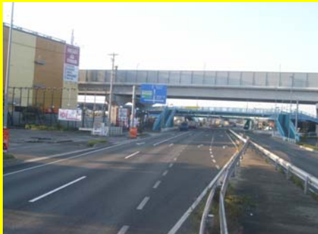
薄層カラー舗装 (施工前)
