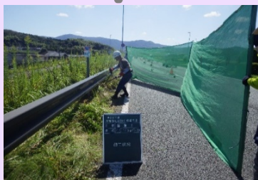
法面の除草作業
