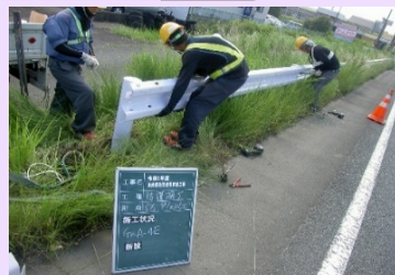
防護柵の復旧作業
