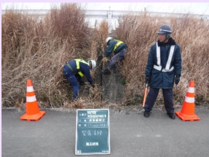
排水施設関係の清掃
