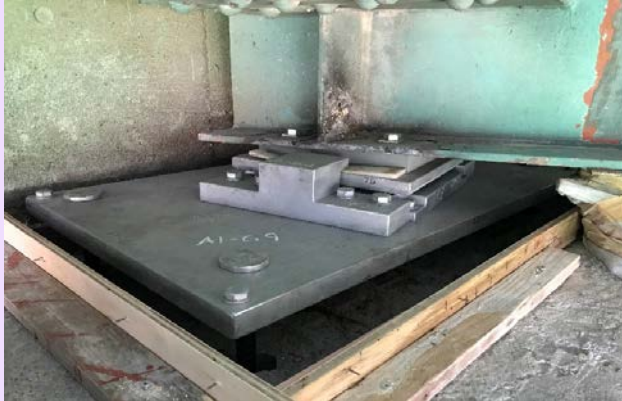
支承取替工（施工状況）
