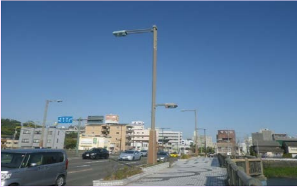
塔世橋 工事着手前風景
