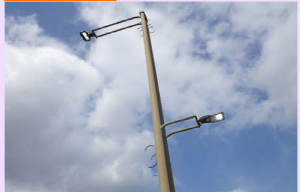
塔世橋 工事完了
