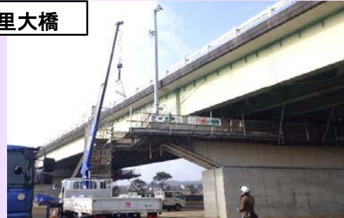
落橋防止装置施工状況
