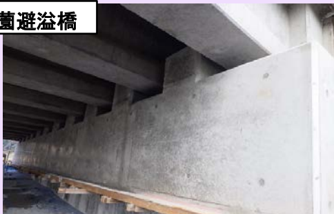
沓座拡幅コンクリート打設完了
