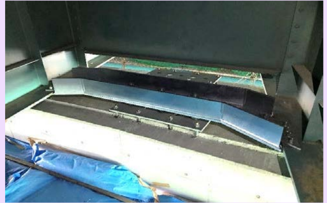
変位制限装置（施工状況）
