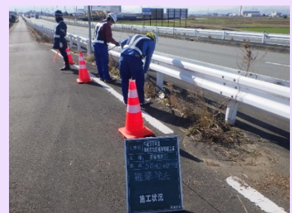
通行等に支障のある雑草の除去
