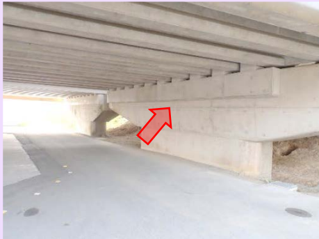
橋梁付属物工完了全景
