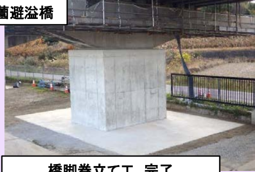
橋脚巻立て工 完了
