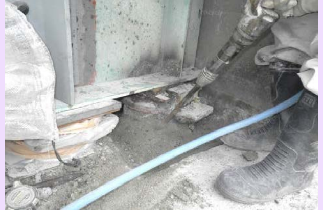
支取替工 旧支取壊し撤去
