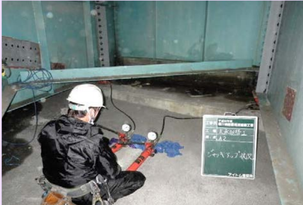
支取替工 ジャッキアップ状況
