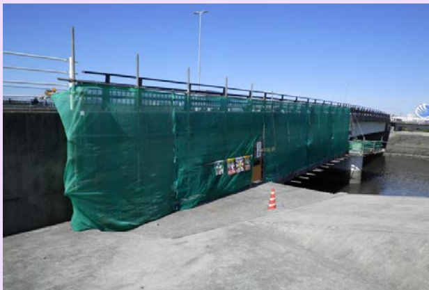
足場設置完了(A2橋台)
