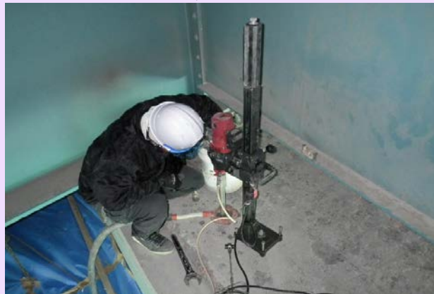
落橋防止装置（削孔状況）
