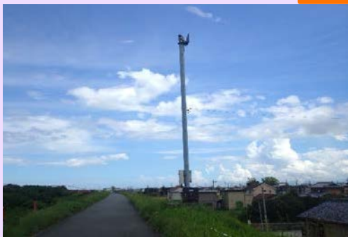
雲出橋観測所CCTV
