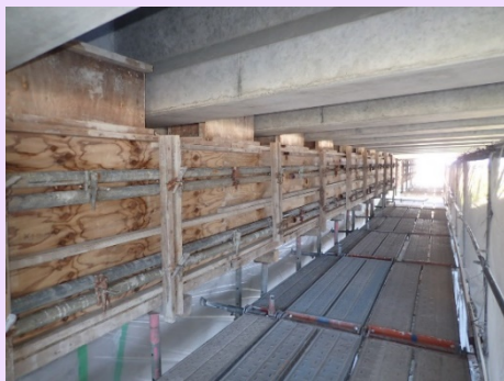
橋梁付属物工 型枠組立完了
