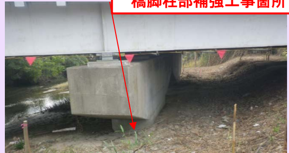
橋脚柱部補強工事箇所
