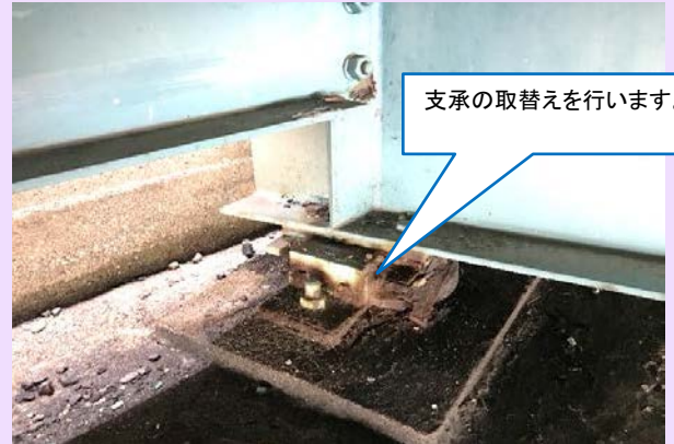
橋梁補修工（支承取替 施工前）
