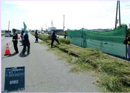
国道23号の除草作業
