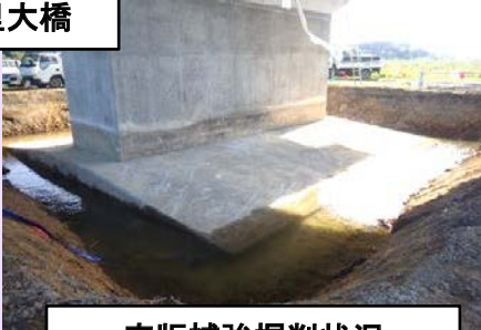
底版補強掘削状況
