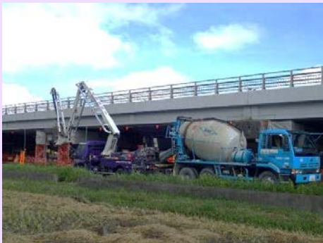
橋梁附属物工 コンクリート打設状況
