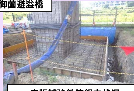
底版補強鉄筋組立状況
