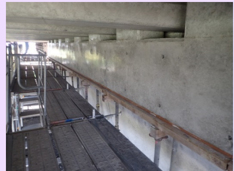
橋梁附属物工 コンクリート打設完了
