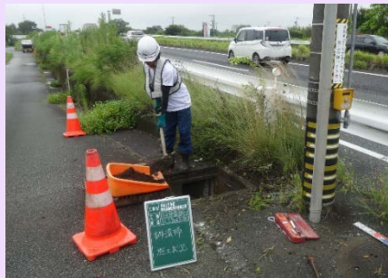
排水施設の清掃作業
