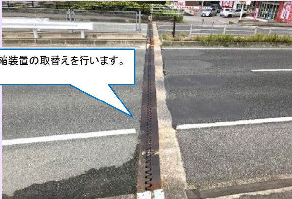
伸縮継手工（施工前）
