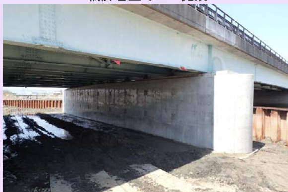
橋脚巻立て工 完成
