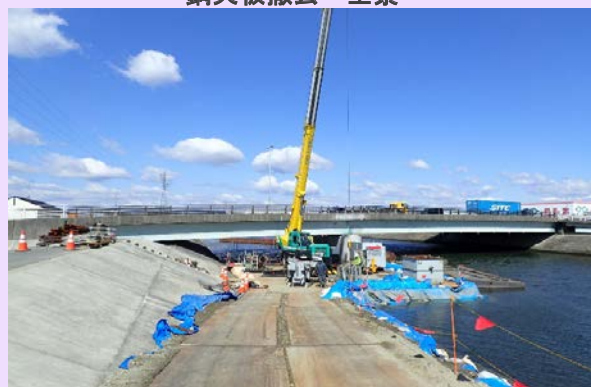
鋼矢板撤去 全景
